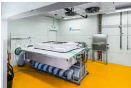
Messkammer für Anlage mit mechanischem Verdichter
